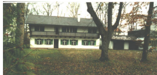
Turnerstraße 42: Das Haus wurde vor dem Ersten Weltkrieg gebaut, nach 1948 aufgestockt. Es wurde 2002 abgerissen
