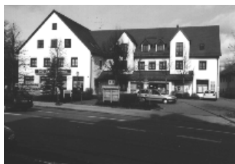
An seiner Stelle wurde 1976 das heutige Bankgebäude errichtet
