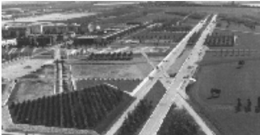
Entstehende Messestadt, links oben Bauabschnitt I. Landschaftspark Blickrichtung nach Osten
